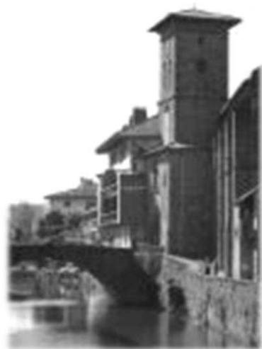
Eglise Notre-Dame-du-Pont à Saint-Jean-Pieds-de-Port
